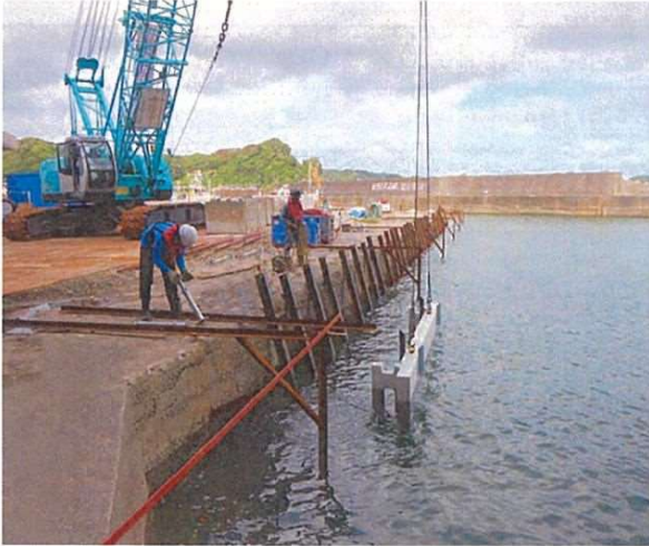
残置型枠据付状況
