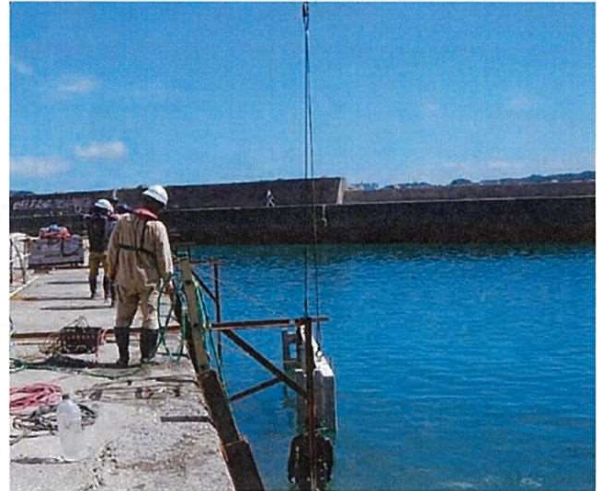
残置型枠据付状況
